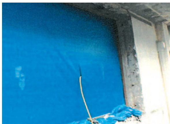
防音工事現場の事例
