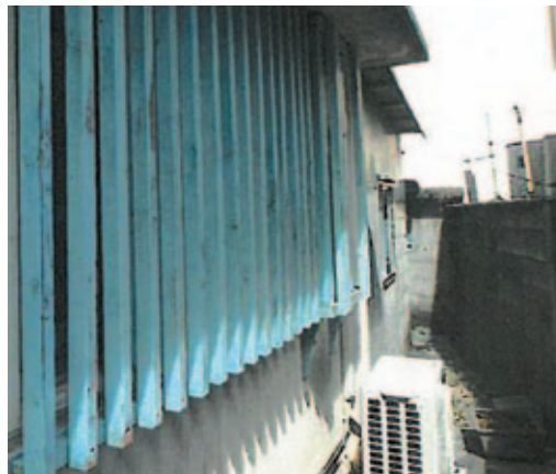
防音工事現場の事例
