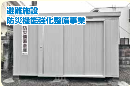
防災備蓄倉庫の設置 (マルチメディアセンター、町民の家、兼久体育館)。
