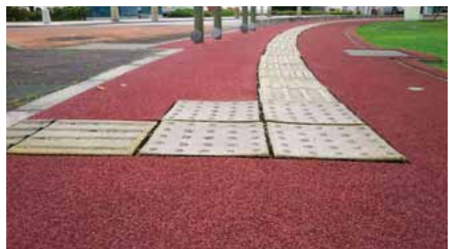
ロータリー広場視覚障がい者用点字ブロック
