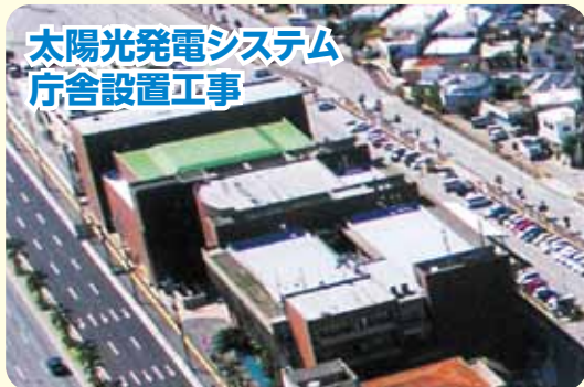
庁舎屋上に太陽光発電システムを設置し電力の省エネ化を図る。
