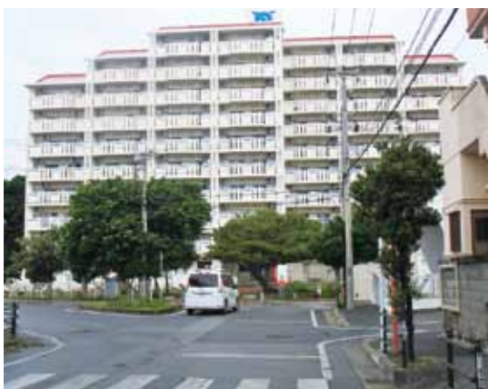
町指定津波避難ビル (町営水釜高層住宅)
