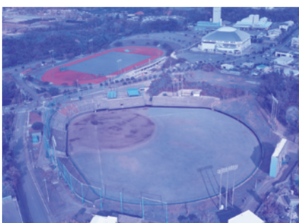
建替または改修を検討中の野球場
