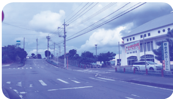
ドーム前交差点滑り止め舗装等工事 (交差点の安全対策工事)
