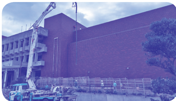
嘉手納文化センター機能向上事業 (多目的トイレの設置、エントランスカーペットの張替)
