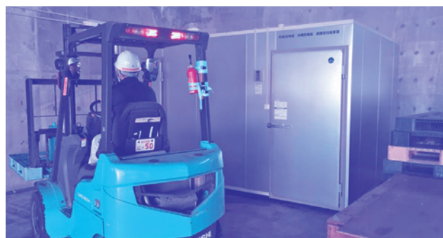
●集出荷施設冷蔵庫設置工事（一括交付金）421 万円
